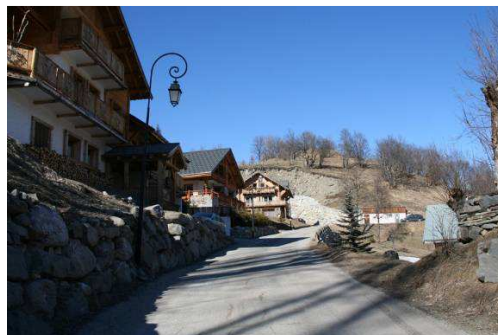
Le Serroz : la pression urbaine est forte, les voies d'accès aux nouvelles habitations marquent fortement le coteau (mur de soutènement).
