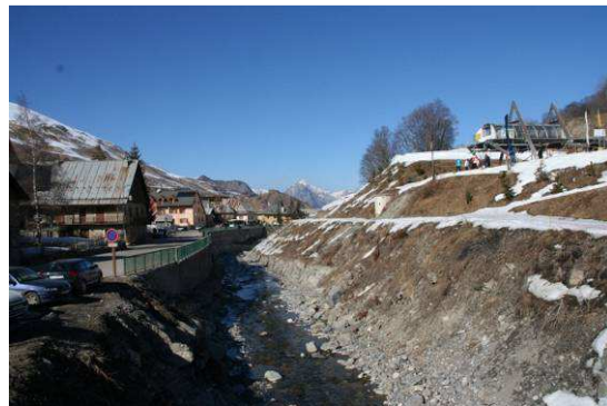
La Valloirette apparait comme une rupture, son aménagement est essentiellement préventif avec les garde-corps.
